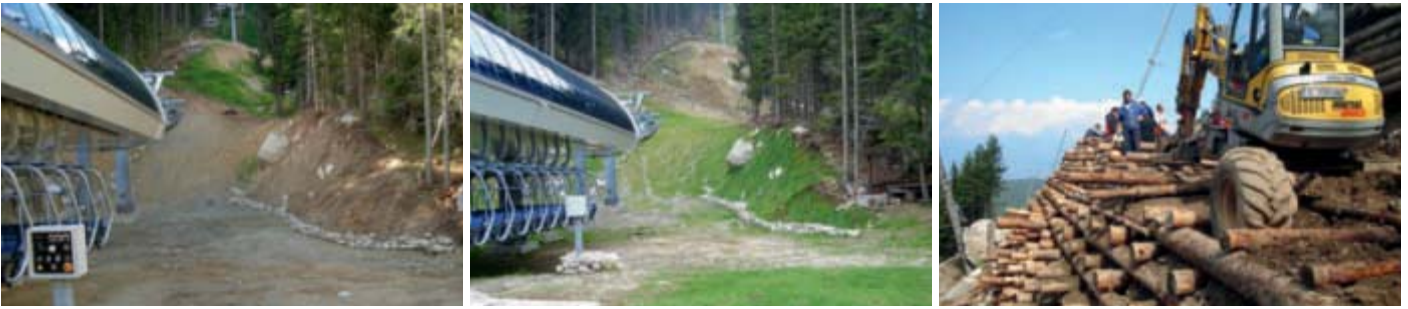
La zone de la gare aval telle qu'elle se présentait au printemps 2011 ... et cette même zone l'automne suivant, après le ré-engazonnement. A droite : Le génie biologique a été mis à contribution pour stabiliser les zones fragiles par des constructions en bois et des plantes, plutôt que d'utiliser le béton et l'acier - ici une paroi Krainer avec ses caissons en bois en construction aux abords de la fameuse descente Tomba.
